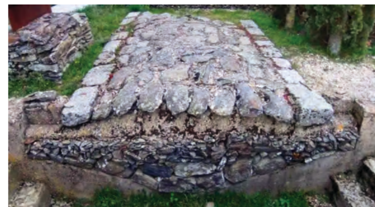
Die Aufnahme lässt den Straßenaufbau der zwischen 2,50 m und 9,00 m breiten Römerstraßen erkennen. Foto: deavita.com
