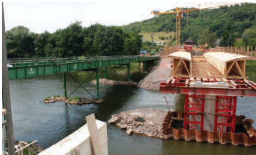
▲ Abriss der alten Brücke und ▼ Bau der neuen (mit Behelfsbrücke) Fotos: Johannes Peters
