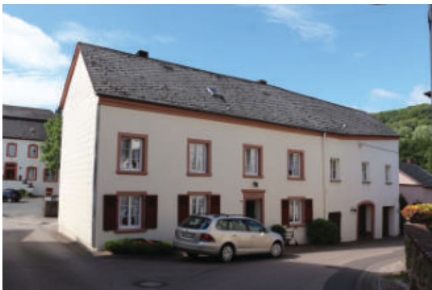
Vorbildliche Sanierung eines weiteren Wiltinger Quereinhauses
