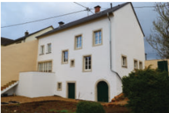
Haus mit Scheunen vor und nach der Sanierung
