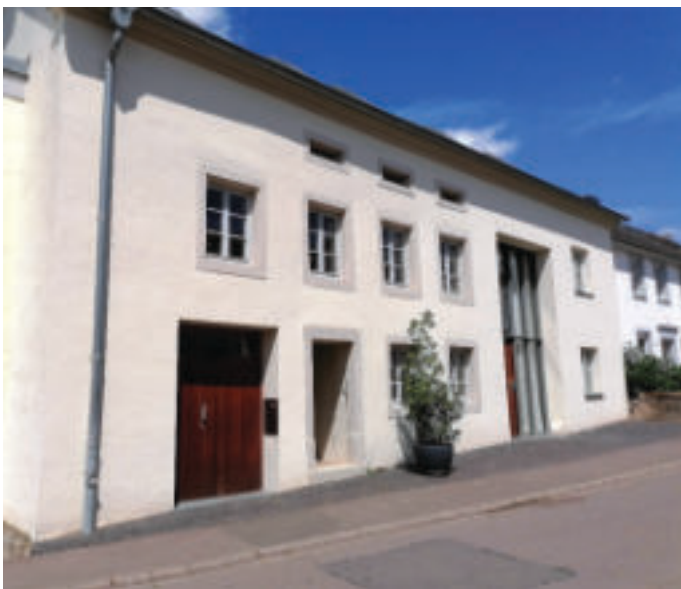
Vorbildliche Sanierung eines Wiltinger Quereinhauses
